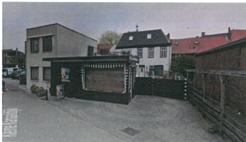
Aanzicht van de bestaande bebouwing (bron: google map)
