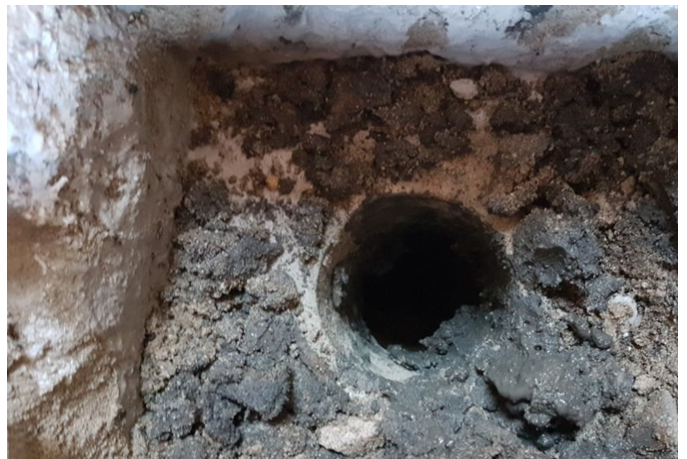
Foto 4: inspectiegat / kernboring BGT2
