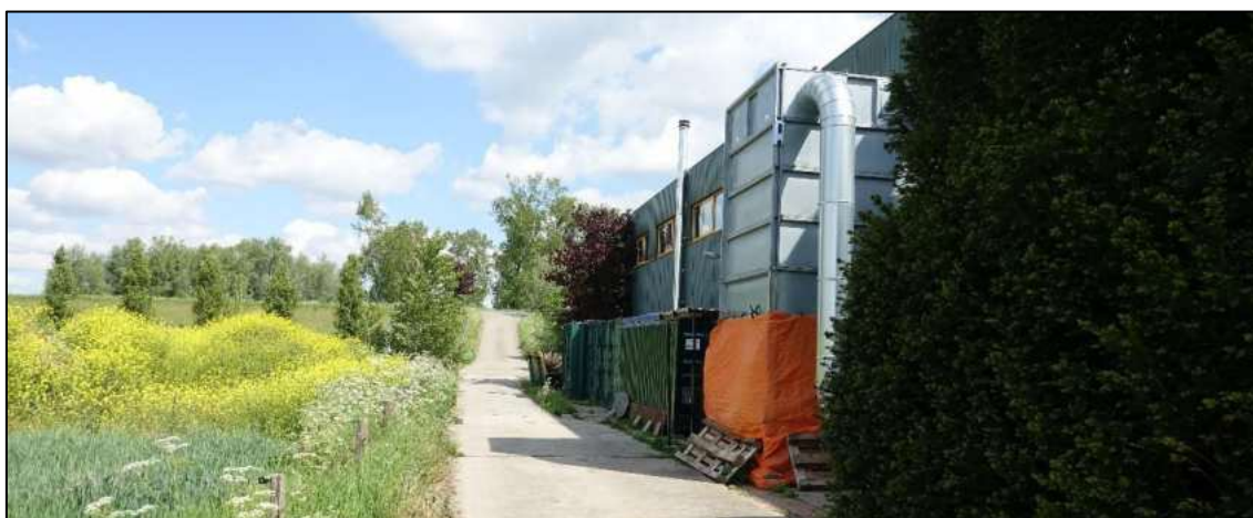
Figuur 3: Langs de westelijke gevel staan verschillende afzuiginstallaties en groeien enkele dichte struiken.
