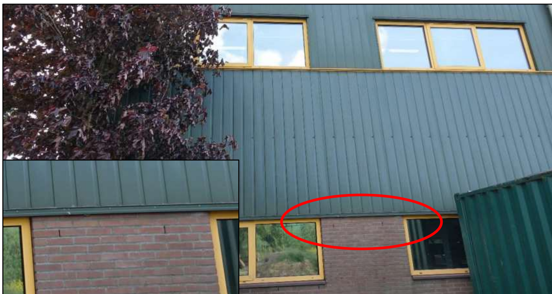
Figuur 8: Opbouw van de gevel van het pand. Ransom zijn in de eerste bouwlaag open stootvoegen aanwezig, waarboven de gevel bekleed is met metalen gevelplaten. De open stootvoegen bevinden zich te laag om functioneel te zijn voor vleermuizen. Inzet: detail van de open stootvoegen.
