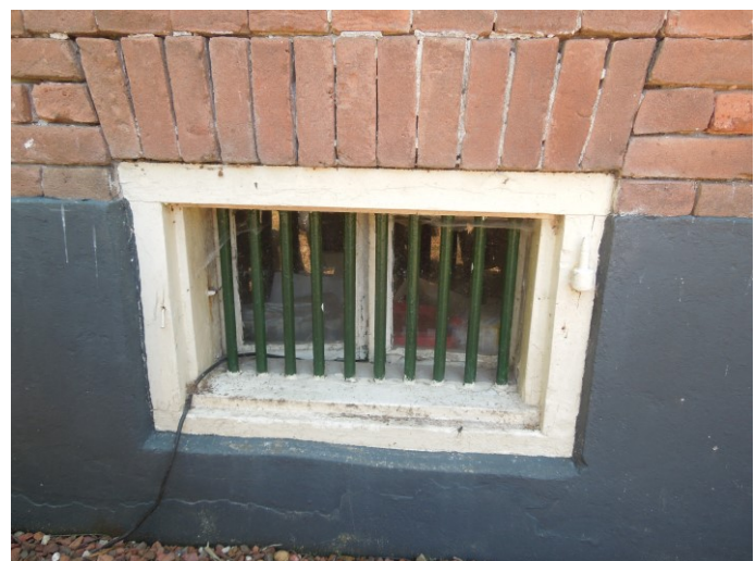
30. De keldervensters zijn voorzien van ronde diefijzers en gemetseld onder een steens strekse boog.
