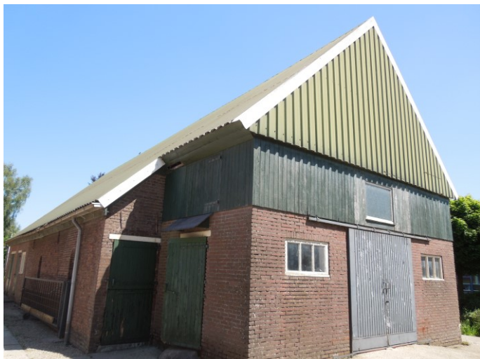
63. De achtergevel van de schuur met later aangebouwde pinkenstal. De kap van de pinkenstal is over het dakoverstek heen gebouwd.
