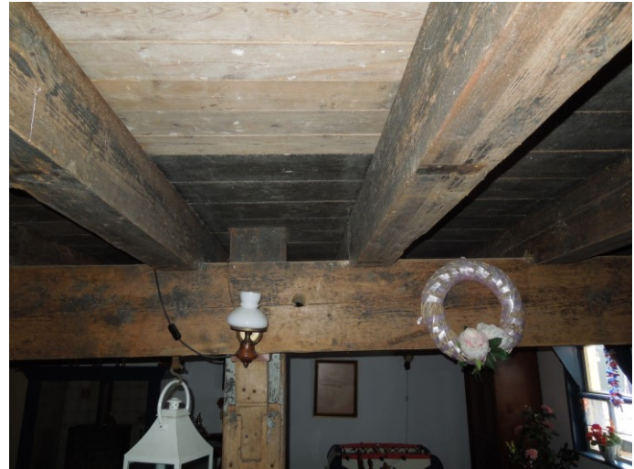
47. De balken van de waterzolder zijn vrij fors en zijn dicht op elkaar aangebracht.
