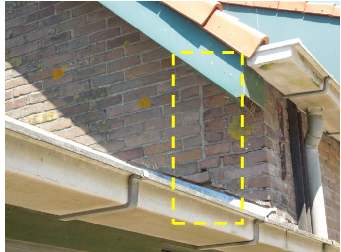
26. In het kader de overgang van het metselwerk uit 1890 (rechts, linker zijgevel) naar het jongere metselwerk van de achtergevel.
