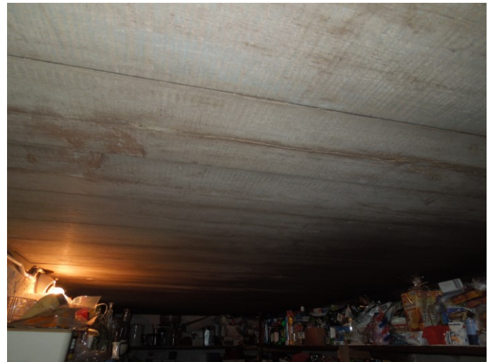
36. Het plafond van de kelder bestaat uit brede, houten delen zonder balklaag.
