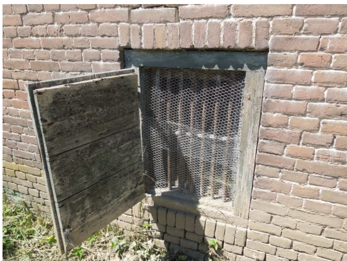
65. Het kozijn van het kelderraam is in elkaar gezet en pen- en gatverbindingen en dateert uit de bouwtijd. Achter het gaas zijn diefijzers zichtbaar.
