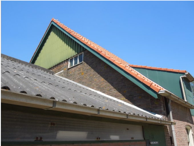
25. De achtergevel van de boerderij. De boerderij moet aan deze zijde net als de schuur een dakoverstek hebben gehad. Dit is niet meer zichtbaar omdat de gevel is versteend.
