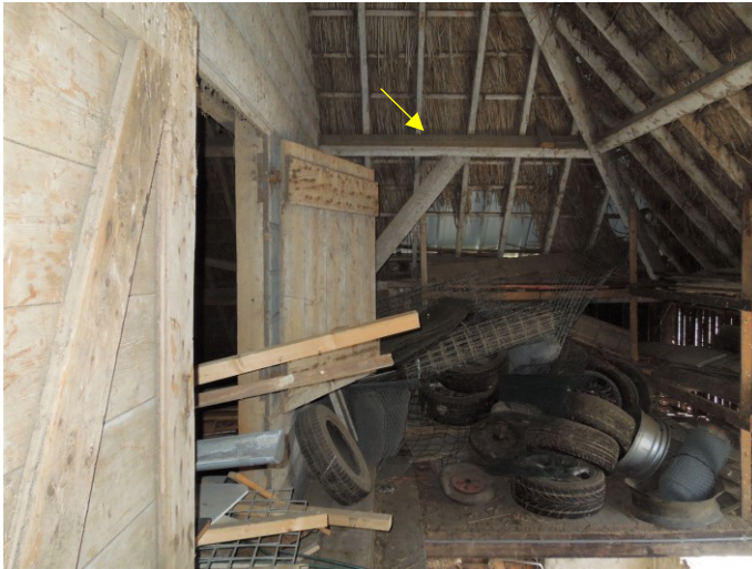
74. Het dakoverstek uit 1890 boven de pinkenstal, met links de achtergevel van de schuur. De gordingen van de kapconstructie zijn doorgetrokken (gele pijl) om de hoekkepers te ondersteunen. Rechts het wolfeind dat boven de achtergevel uitstak. De planken van de achtergevel rechts zijn niet geteerd omdat het overstek het hout beschermde tegen weersinvloeden.
