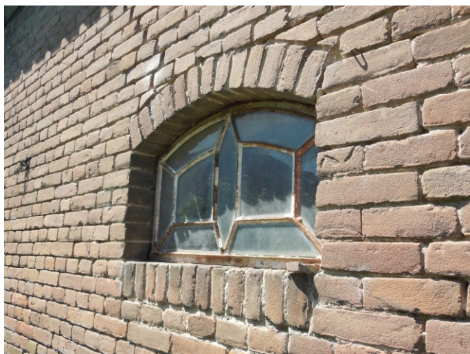
66. Eén van de gietijzeren stalramen in de linker zijgevel.
