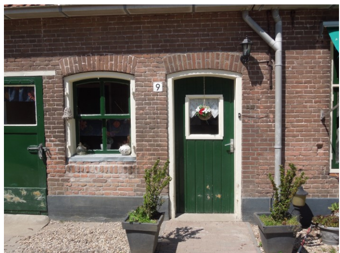
24. De originele opening voor de staldeur (rechts) onder een steense segmentboog met daarnaast een stalraam uit de bouwtijd.
