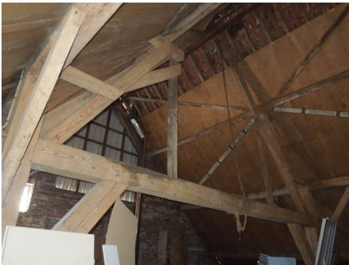
53. Driehoekspant boven een ankerbalkgebint.
