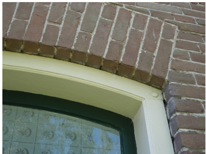
22. De kozijnen zijn aangebracht onder een anderhalfsteense segmentboog en in elkaar gezet met pen- en gatverbindingen.
