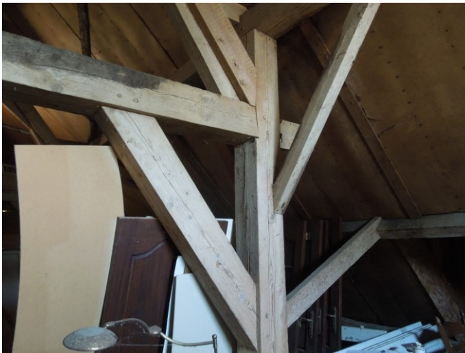
51. Detail van het ankerbalkgebint op de hooizolder (1.10).
