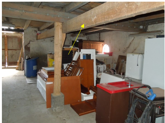
71. Na de bouwtijd zijn voor de stal twee onderslagbalken aangebracht (gele pijl).
