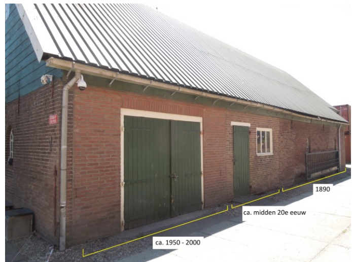
60. De rechter zijgevel van de schuur bestaat uit metselwerk uit verschillende perioden.
