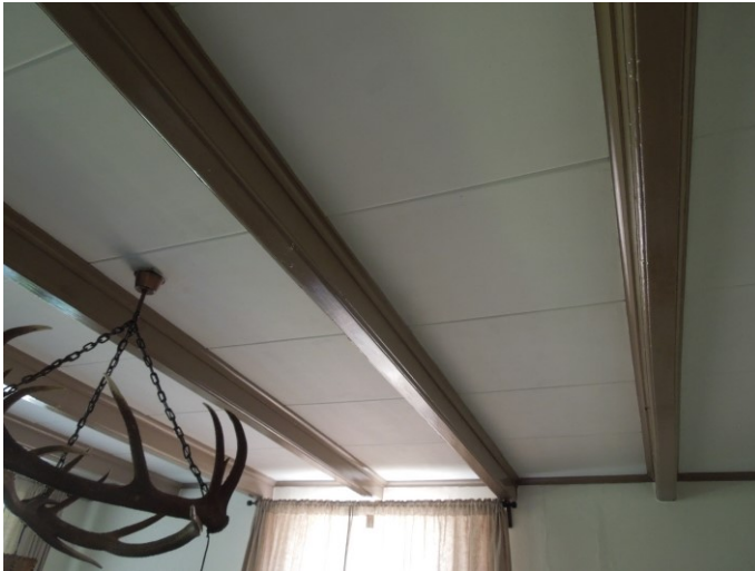
40. Het voorhuis en de eerste travee achter de brandmuur zijn voorzien van een enkelvoudige balklaag (0.6)
