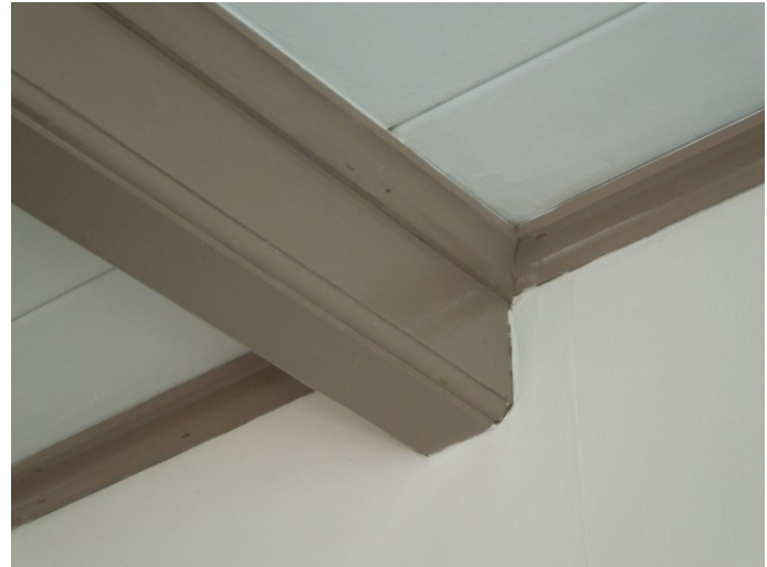
41. Detail van één van de balken met aan de onderzijde een duivejagerprofilering (0.6).
