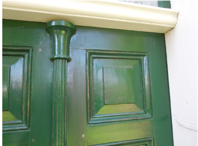
20. Detail van de voordeur met middenstijl met cannelures en geprofileerd kalf.
