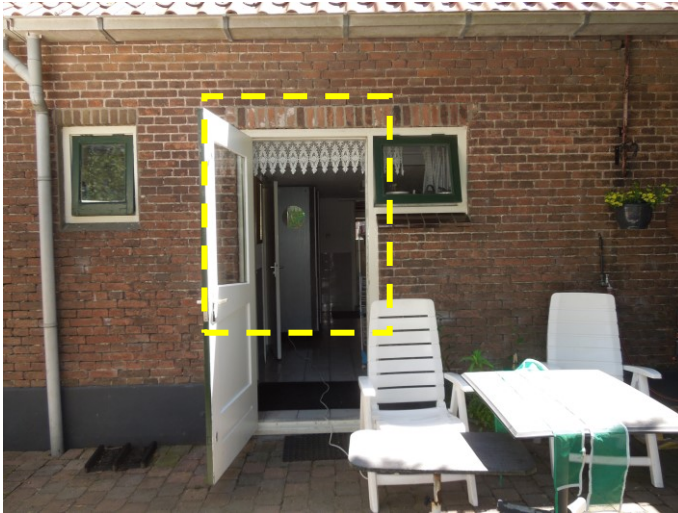
31. De deur met zijlicht onder een steense rollaag ter plaatse van een voormalig stalraam.
