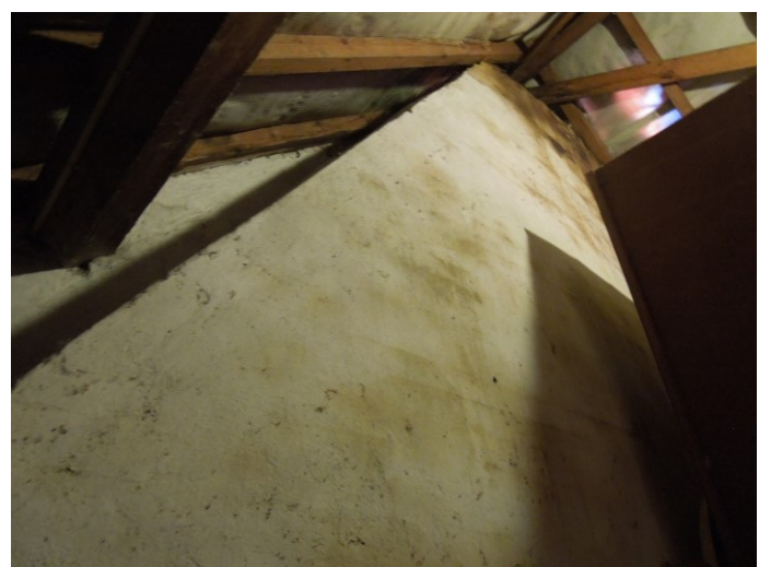
56. Het conisch gemetselde rookkanaal van de werkschoon tegen de achterzijde van de brandmuur.
