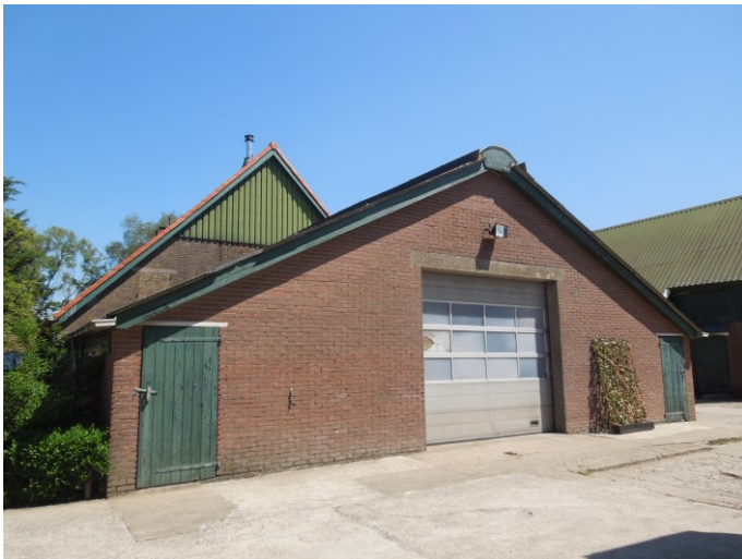
27. De achtergevel van de aangebouwde stal.
