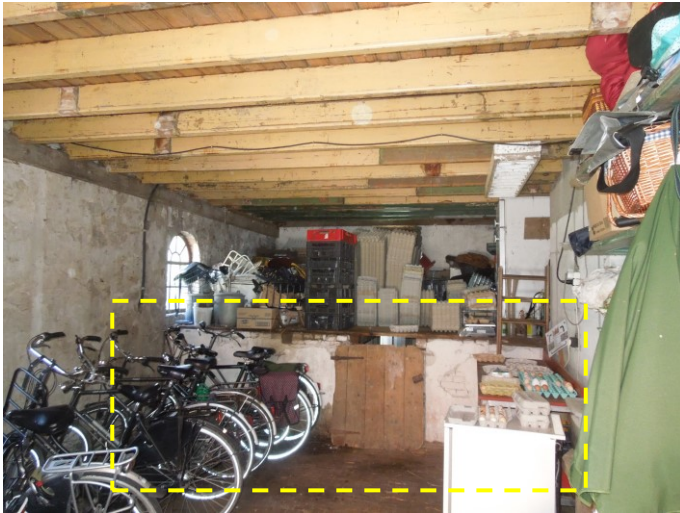
68. Ruimte 0.1 gezien richting de linker zijgevel met half verdiept de kelder (-1.1, geel kader).
