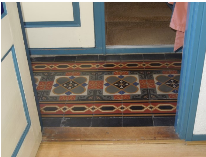
42. In hal 0.7 zijn de gekleurde cementtegels uit 1890 herplaatst die van oorsprong in de gang (0.4) lagen.
