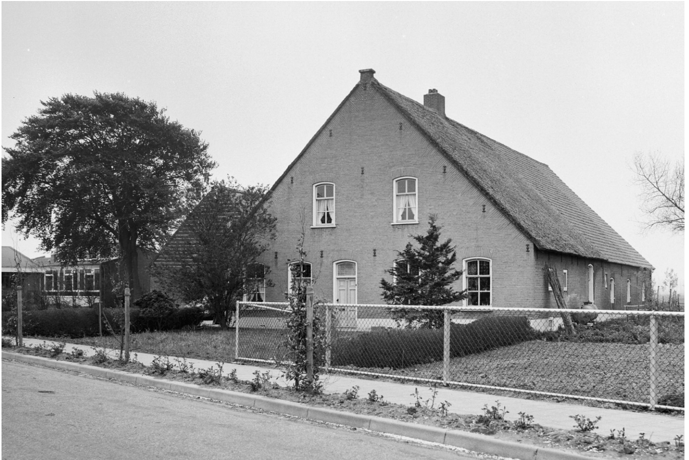
7. De boerderij in 1979 met links achter het pand de schuur met houten topgevel. De voorgevel van de boerderij is min of meer symmetrisch met net uit het midden een deur met bovenlicht en aan weerszijden tweemaal twee zesruits schuifvensters. Ook op de verdieping zijn twee schuifvensters aangebracht. De voorgevel betreft een gemetselde tuitgevel met rozetankers. De rechter zijgevel van de boerderij bestaat uit twee kleine, hoge opkamervensers, een hoog vensters onder een segmentboog en drie stalramen. Het voorste deel van het dak is gedekt met riet, het achterste deel met pannen. Afbeelding: Rijksdienst voor het Cultureel Erfgoed, Amersfoort/ 205.838
