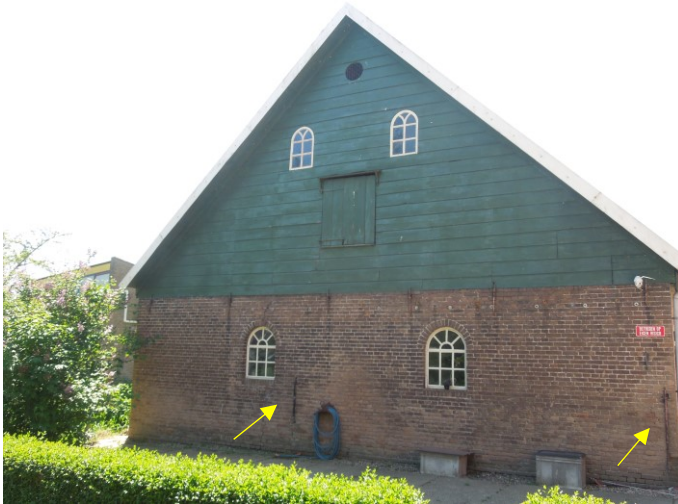
57. De voorgevel van de schuur met de locaties van de twee gekoppelde muurankers (gele pijlen).
