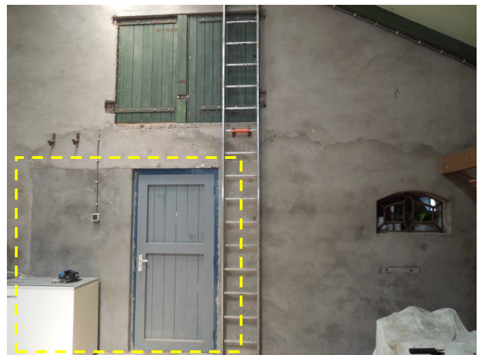
49. De gemetselde achtergevel van de boerderij vanuit de nieuwe stal met enkele deur (was breder), gietijzeren stalraam (afwijkend van de houten stalramen) en luiken op de verdieping.
