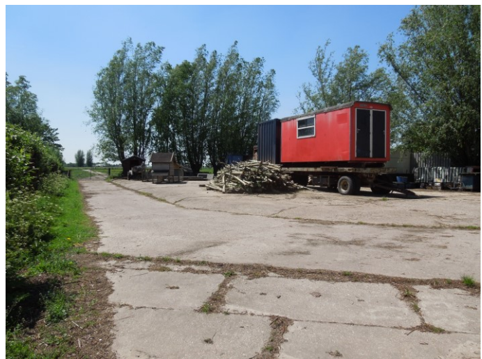
16. Grote delen van het erf achter de boerderij zijn voorzien van betonnen platen.
