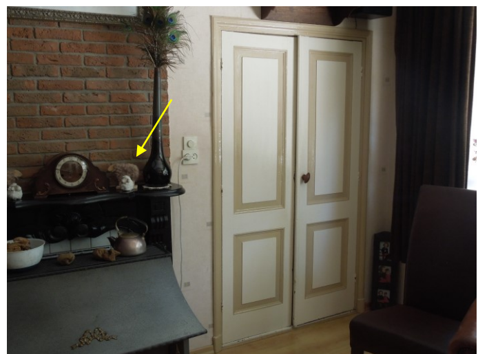
45. De paneeldeuren in de brandmuur vanuit kamer 0.9 met links de schoorsteenmantel (gele pijl).
