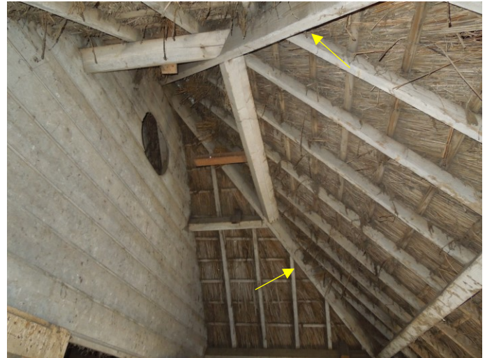
75. De constructie van het dakoverstek gezien naar boven toe met de twee hoekkepers (gele pijlen) die de constructie vormen. Het overstek is gedekt met riet. Het feit dat de schuur een dakoverstek heeft, betekent dat de boerderij er ook een moet hebben gehad. Het kon voorkomen dat een boerderij een dakoverstek had en de schuur niet, maar niet andersom.
