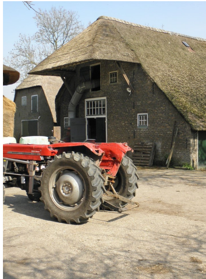
77. Het dakoverstek tegenwoordig. Onder het overstek kon de hooiwagen droog worden gestald waarvandaan het hooi op de zolder kon worden gestoken.
