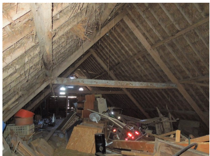
73. De kapconstructie van de schuur gezien richting de voorgevel met drie schaarspanten.
