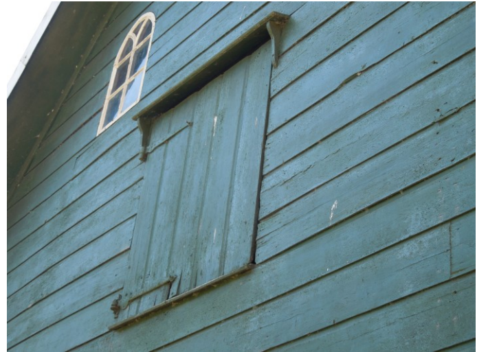
58. Detail van het booiluik in de voorgevel onder een houten afdakje.
