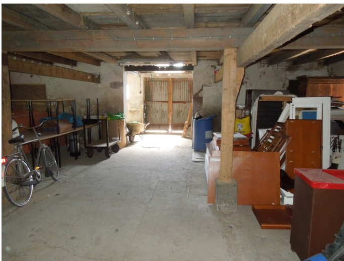
70. De voormalige stal (0.2) gezien richting de aangebouwde pinkenstal.
