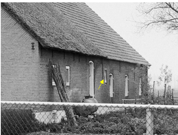
29. De rechter zijgevel in 1979 ter vergelijking. In de zijgevel zijn nog geen deuren. Het toiletraampje naast het voorste stalraam (gele pijl) is na de bouwtijd aangebracht. Afbeelding: RCE, Amersfoort/ 205.838 (detail)
