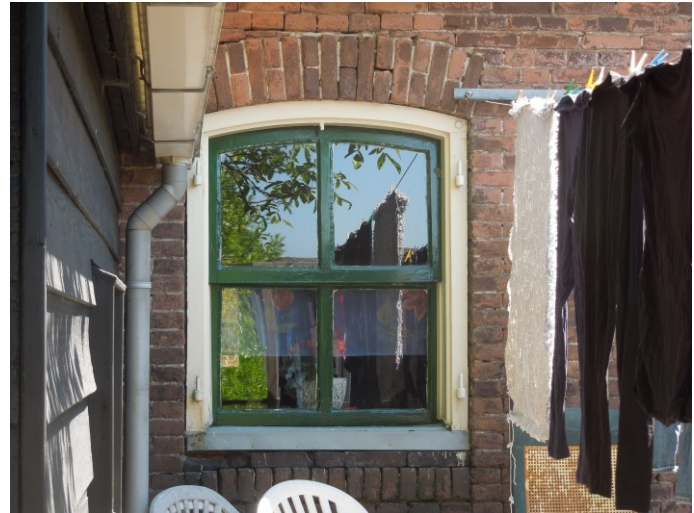
32. Stalvenster met kozijn en vierruits schuifraam uit de bouwtijd. In de kozijnen zijn duimen aangebracht waaraan luiken hingen.
