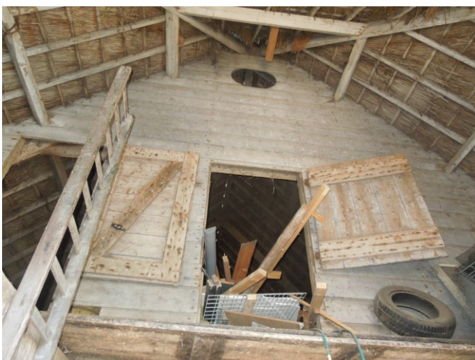
72. De oorspronkelijke houten achtergevel van de boerderij met twee houten luiken. Het luik links is vermoedelijk aangebracht met de pinkenstal. Bovenin de top een ronde vensteropening net als in de voorgevel.
