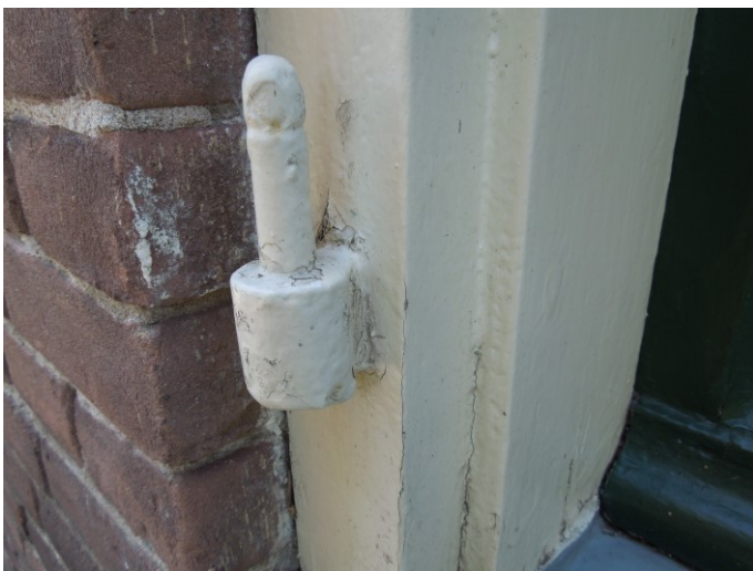
21. In de kozijnen van de ramen zijn duimen uit de bouwtijd aanwezig waaraan de luiken hing.
