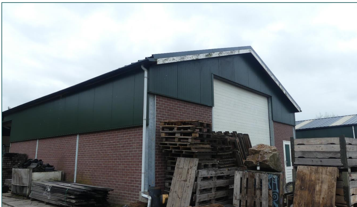
Figuur 1.4 De bedrijfsgebouwen op de planlocatie bevatten muren opgetrokken uit bakstenen met kunststof gevelbekleding.
