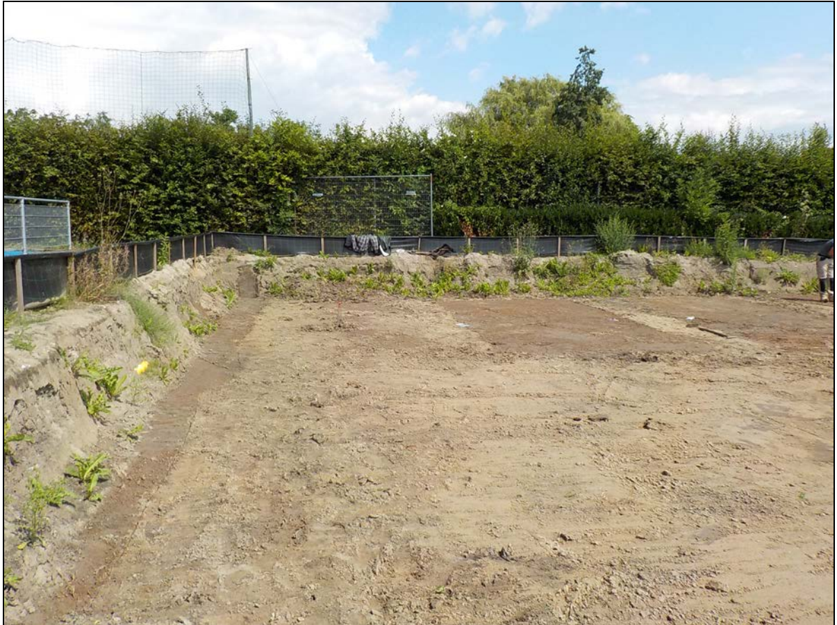
Afbeelding 6. Het noordwestelijke deel van de bouwput na het opschonen van het eerste vlak. De met bouwzand gevulde verstoringen van het voormalige schoolgebouw (kruipruimte en funderingsstroken) zijn duidelijk zichtbaar.
