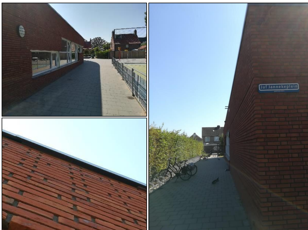
Afbeelding 2: Indruk van de school en de noordmuur aan welke zijde de uitbreiding plaats gaat vinden (foto's: Laneco 2021).
