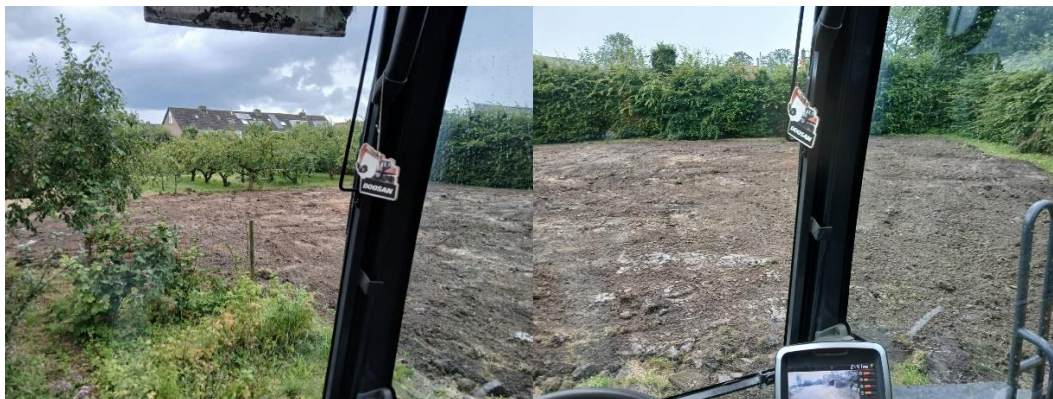
Afb. 5. Oplevering van het terrein.
