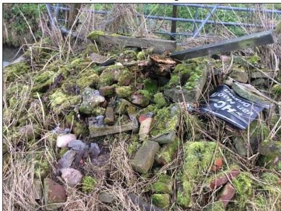
Foto 3 dam met puin (t.h.v. boring 08)
