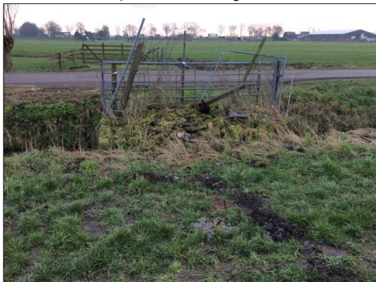
Foto 1 dam met puin (t.h.v. boring 08)
