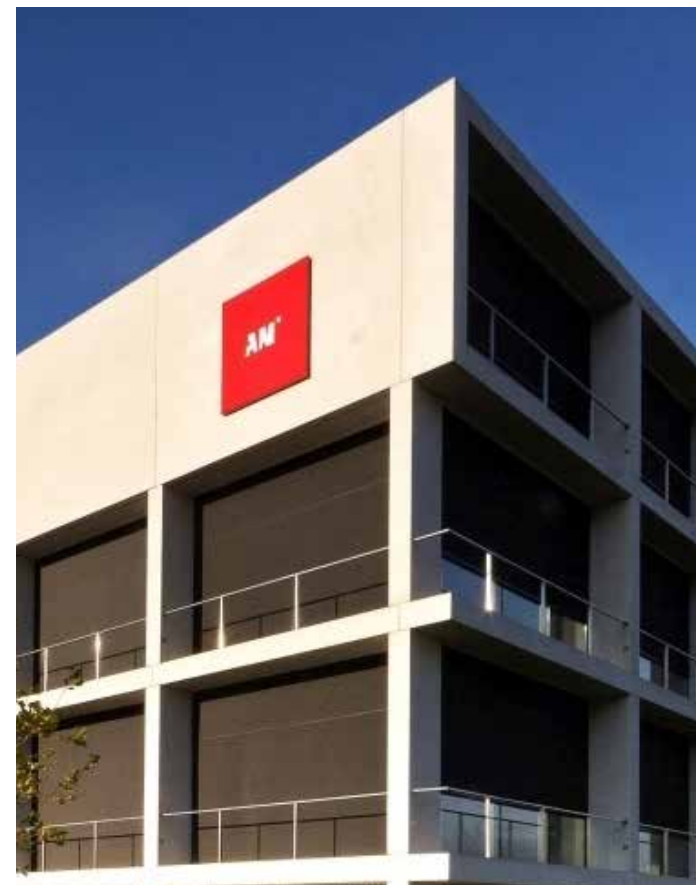
reclame-uitingen blijven binnen gebouwcontour
