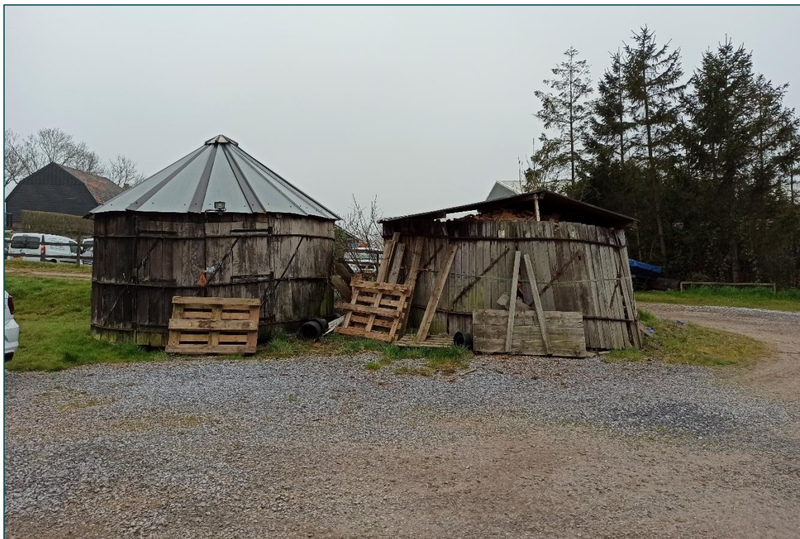
Figuur 3 Er zijn tevens twee houtopslagloodsen aanwezig.
