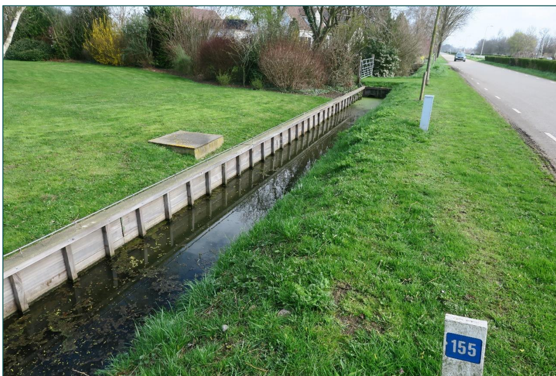
Figuur 4 Impressie van de beschoeide sloot aan de zuidoostelijke zijde van de planlocatie.
