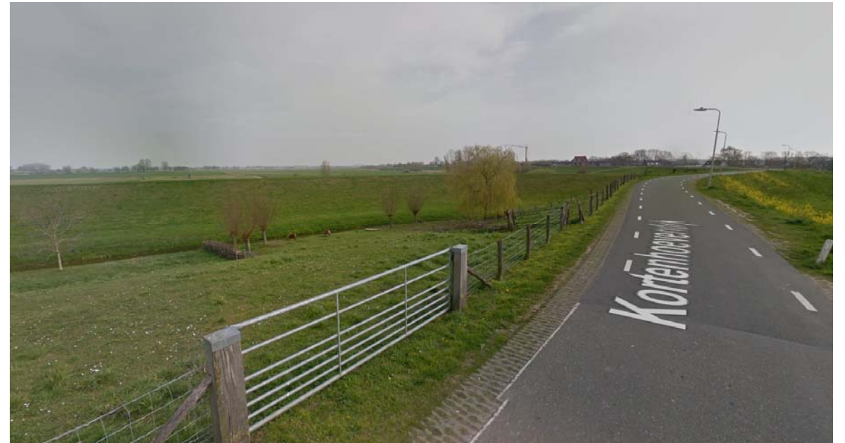
3. Zicht op bestaand perceel en uiterwaarden aan buitenzijde Kortenhoevendijk, dijklichaam en bomen
