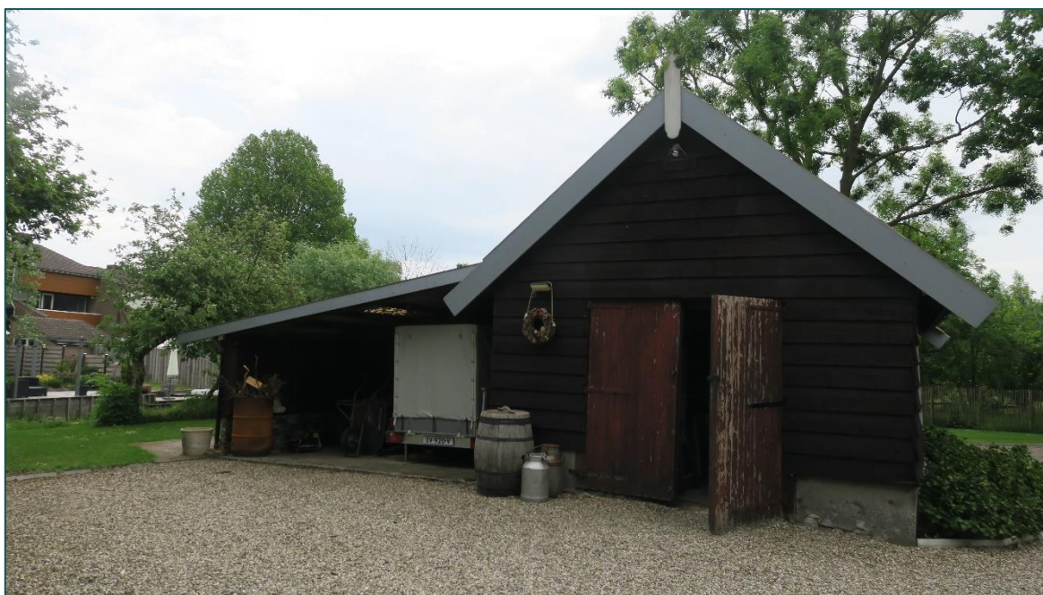
Figuur 2 De te slopen schuur.
