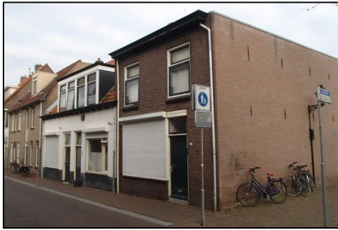
Aanzicht plangebied vanaf de hoekwoning aan de Nieuwstraat
