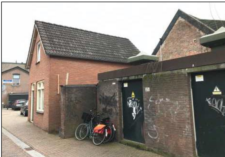
Bebouwing van het plangebied aan de Bergstraat (bron: Den Haan)
