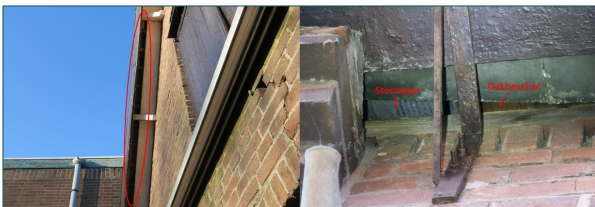
Figuur 3.2 Links: missende plank in dakoverstek. Alhoewel de dakruimte toegankelijk is, betreft het geen geschikte verblijfplaats gezien de afwezigheid van een geschikt microklimaat. Rechts: opening aan de onderzijde van de dakgoot. Ook is hier geen sprake van een geschikte verblijfplaats gezien de stormpan direct op het dakbeschot is geplaatst en er daardoor geen ruimte onder het dak aanwezig is.
