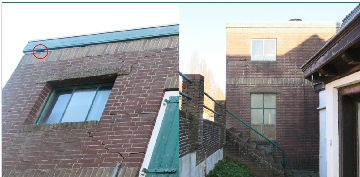
Figuur 3.1 In werkplaats 2 is een invliegopening aanwezig voor vleermuizen in de vorm van een weggevallen steen (links). Gezien de bebouwing beschikt over een plat dak, er geen sprake is van een luchtsponw en er veel lichtinval is in de bebouwing (rechts), beschikt de werkplaats niet over een geschikte verblijfplaats voor vleermuizen.
