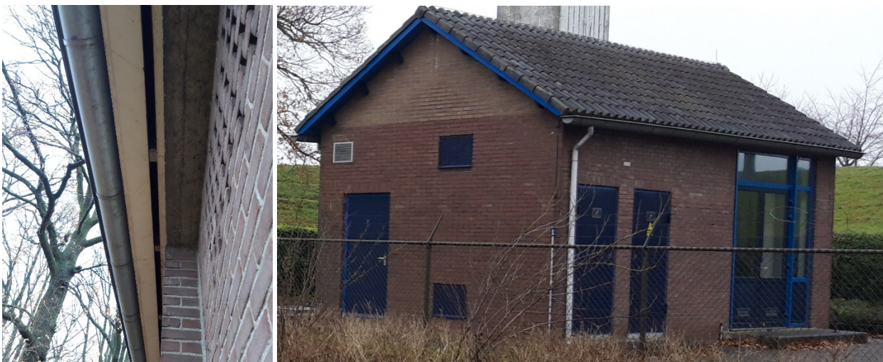
Figuur 5-1 Links: Een impressie van de houten constructie onder de dakgoot van het brugwachtershuisje, Rechts: in impressie van het generatorhuisje. Foto's Royal HaskoningDHV, 2019
