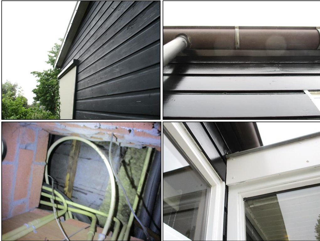
Figuur 5 In de tijdelijke woning zijn geen openingen waargenomen die leiden naar ruimtes waar gebouwbewonende vleermuizen gebruik van kunnen maken. Onder het dak is tevens geen dakbeschot aanwezig (linksonder). Hierdoor ontbreekt er een ruimte tussen het dak en het dakbeschot waar vleermuizen tussen kunnen gaan zitten.
