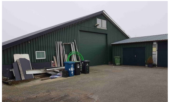
Foto 4: voormalige zeugenstal, noordwestzijde locatie (vanaf zuidoostzijde)
