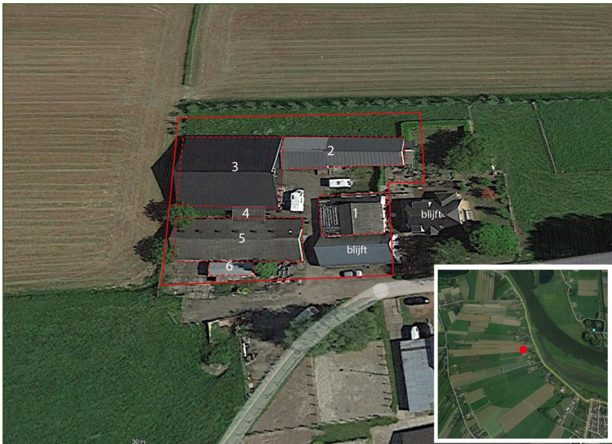
Figuur 2. Luchtfoto projectgebied met opstalnummering (bron: Google earth)
