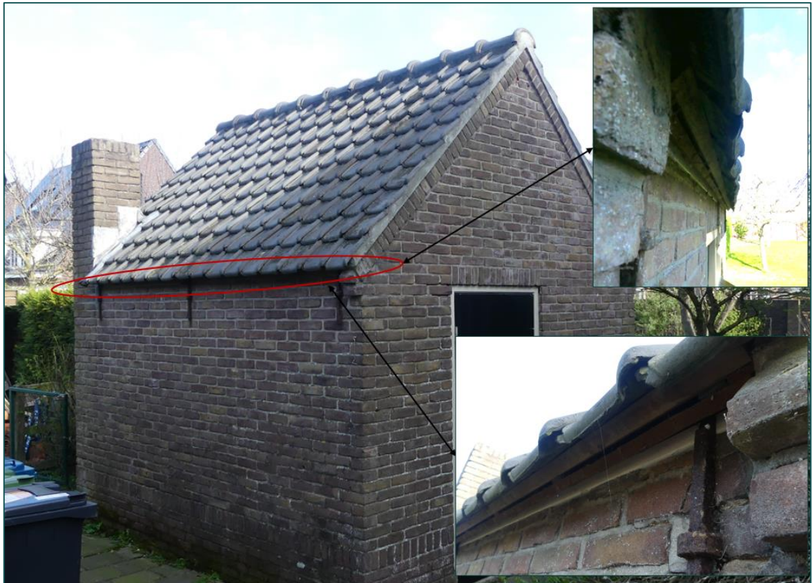
Figuur 3.3 In schuur B zijn geen openingen aanwezig. Aan de dakvoet zijn geen openingen die huismussen toegang geven tot geschikte nestlocaties.
