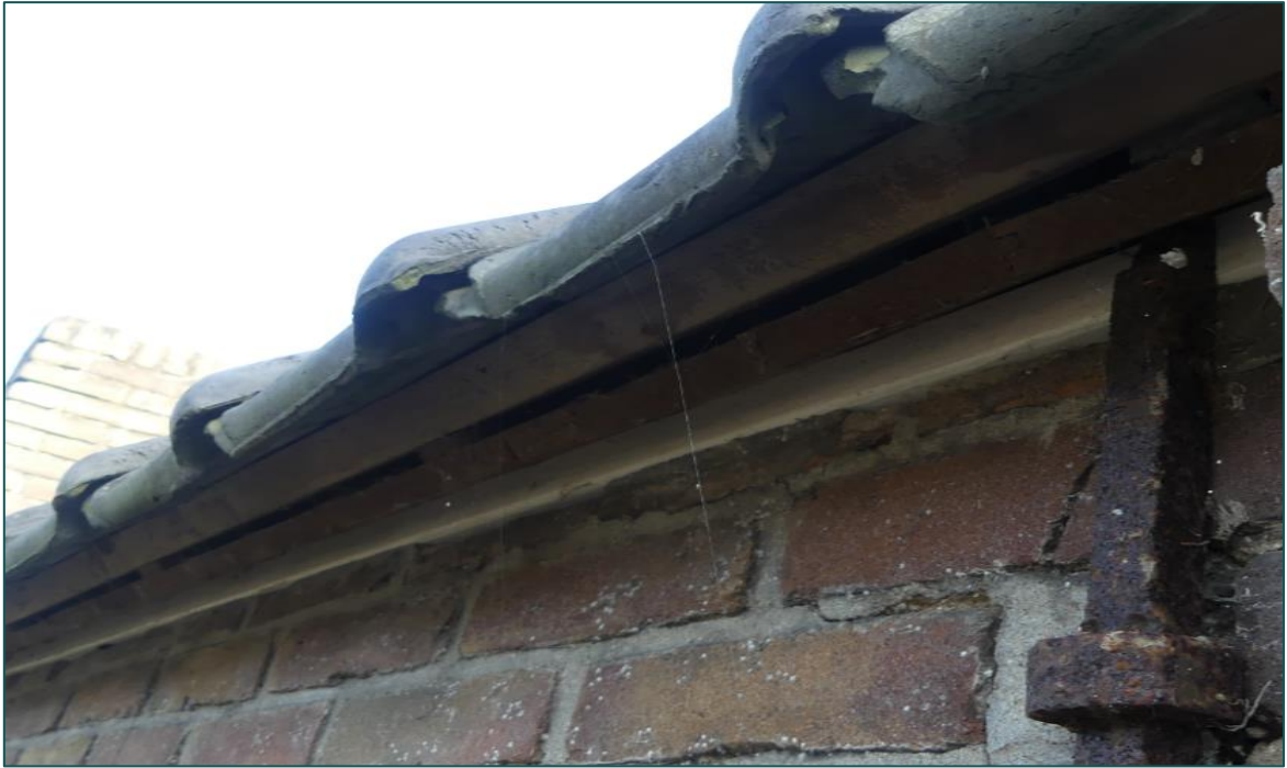
Figuur 3.1 Het dak van schuur B is belegd met stormpannen, deze sluiten de toegang tot de ruimte boven het dakbeschoot hermetisch af. De kier onder het dak komt uit in de schuur, echter ontbreken geschikte wegkruipruimtes.
