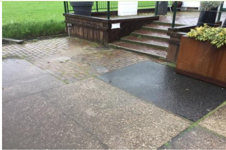
Foto 2; Bufferstrook achterzijde (klinkers t.p.v. gat 12)
