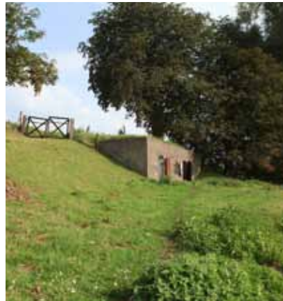
batterijen en betonwerken Meerdijk
