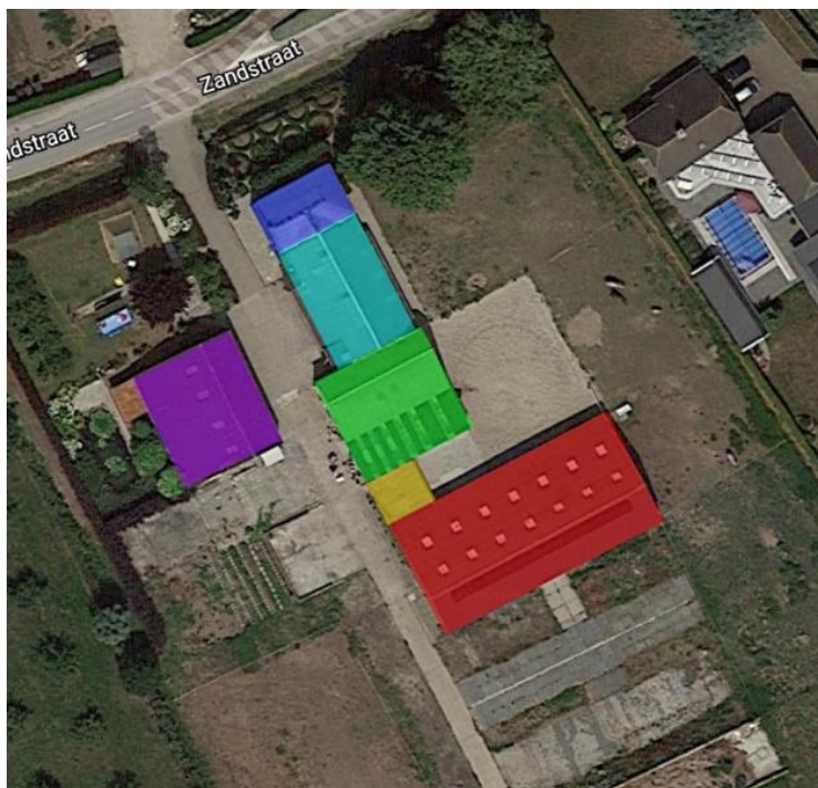
Figuur 6. Gebouwen op het perceel.
