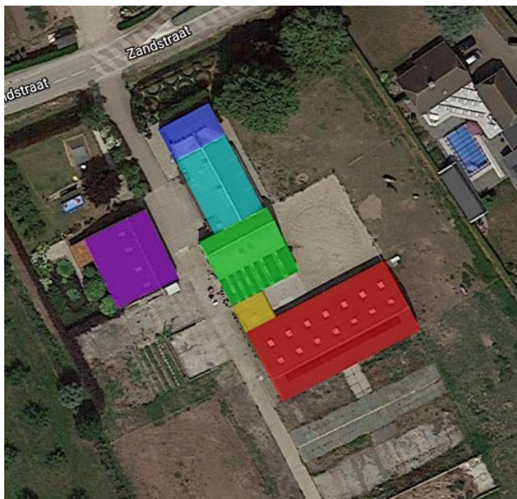
Figuur 6. Gebouwen op het perceel.
