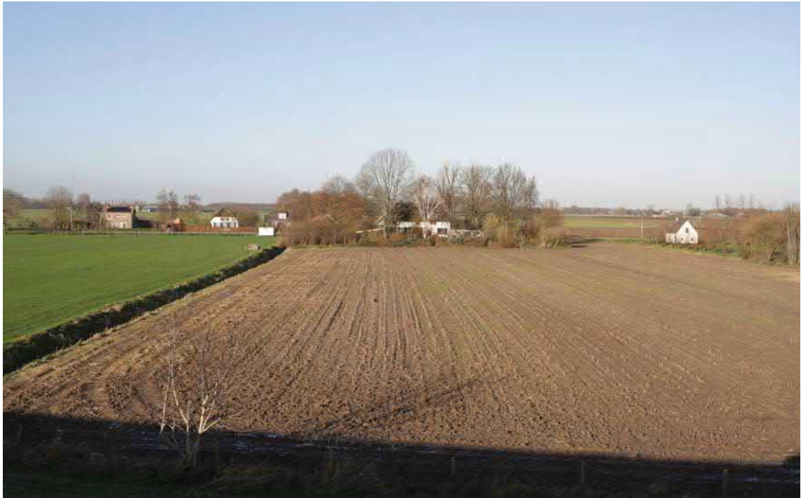
Figuur 4.15. Ten oosten van Opijnen is de dijk teruggelegd op een oeverwal.
