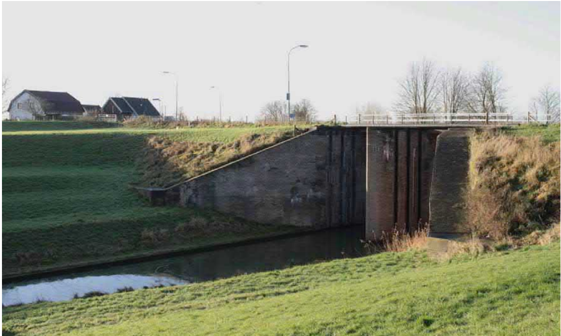
Figuur 2.11. Inlaatsluis in het Inundatiekanaal bij Tiel.
