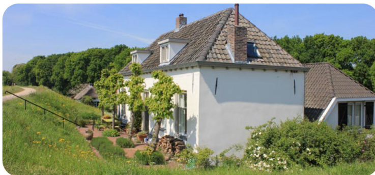
2 Huizen aan de dijk
