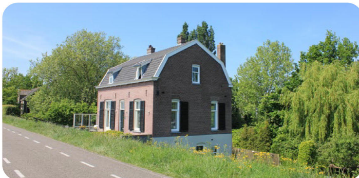
3 Huizen aan de dijk
