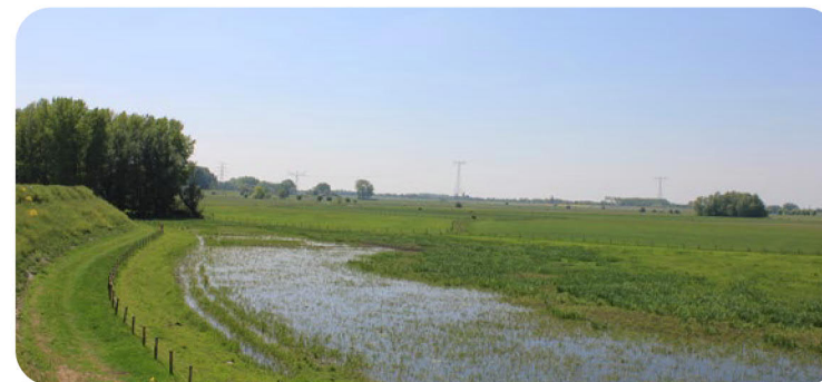
5 Afgetiggelde laagte bij de dijkdoorbraak
