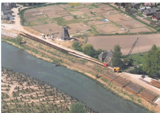
Figuur 2-3: Aanleg kistdamman
