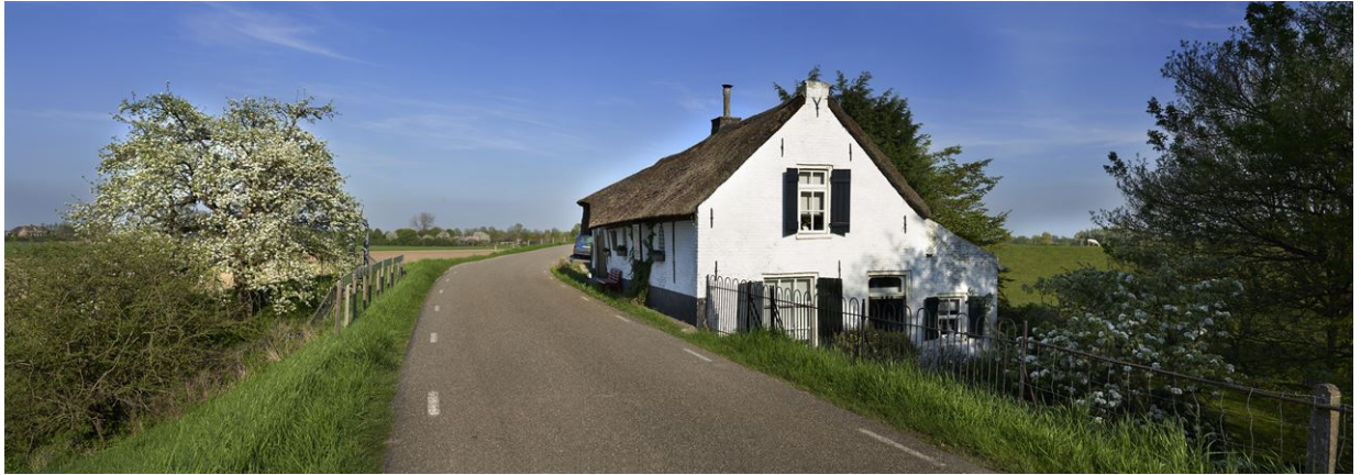
Figuur 2.10 Foto van de dijk
