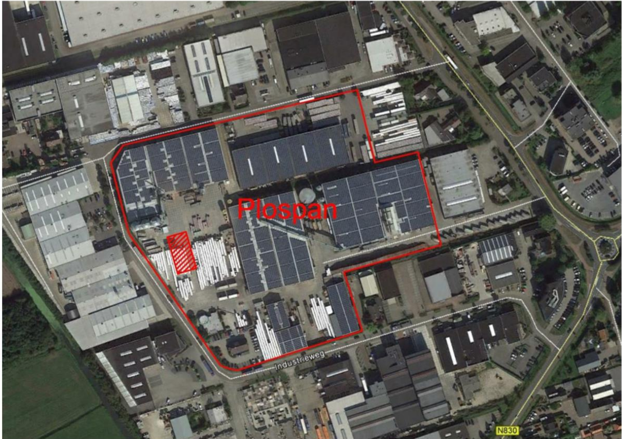
Figuur 1 Locatie van de geplande biomassacentrale bij Plospan
