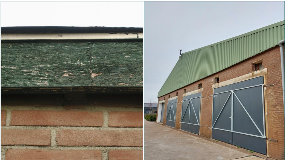
Figuur 3.1 Links: houten lijst tegen de muur (1). Onder het hout bevindt zich een rand beton waardoor vleermuizen niet verder omhoog kunnen. Rechts: openingen in het gebouw (2) die niet tot de spouw leiden, maar direct de loods in.
