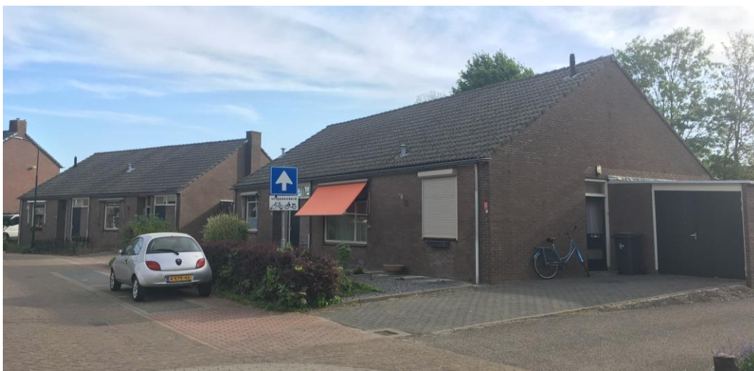
Figuur 3 De planlocatie aan de Koningin Wilhelminalaan betreft 4 twee-onder-een-kap woningen.
