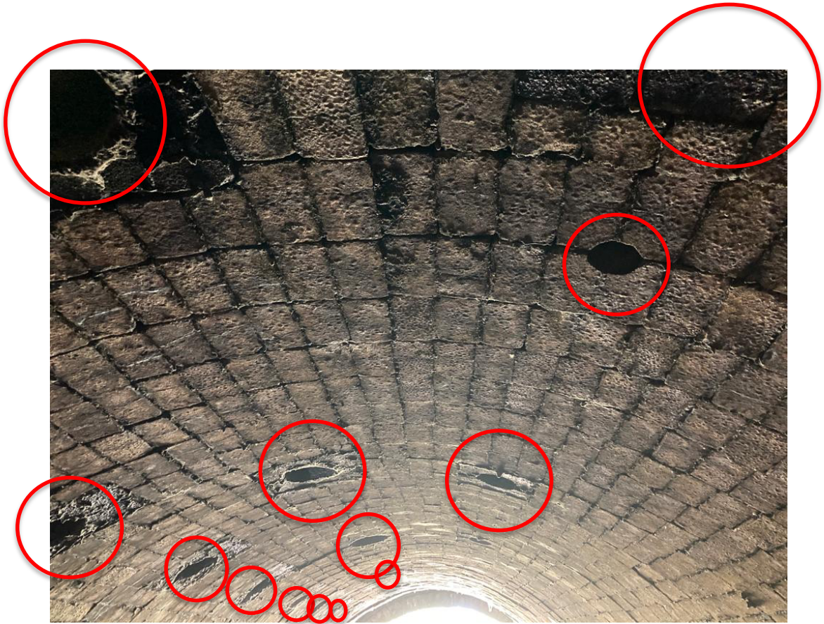
Figuur 3. Een foto van het plafond van één van de steenovens met de openingen van de schoorstenen rood omcirkeld.
