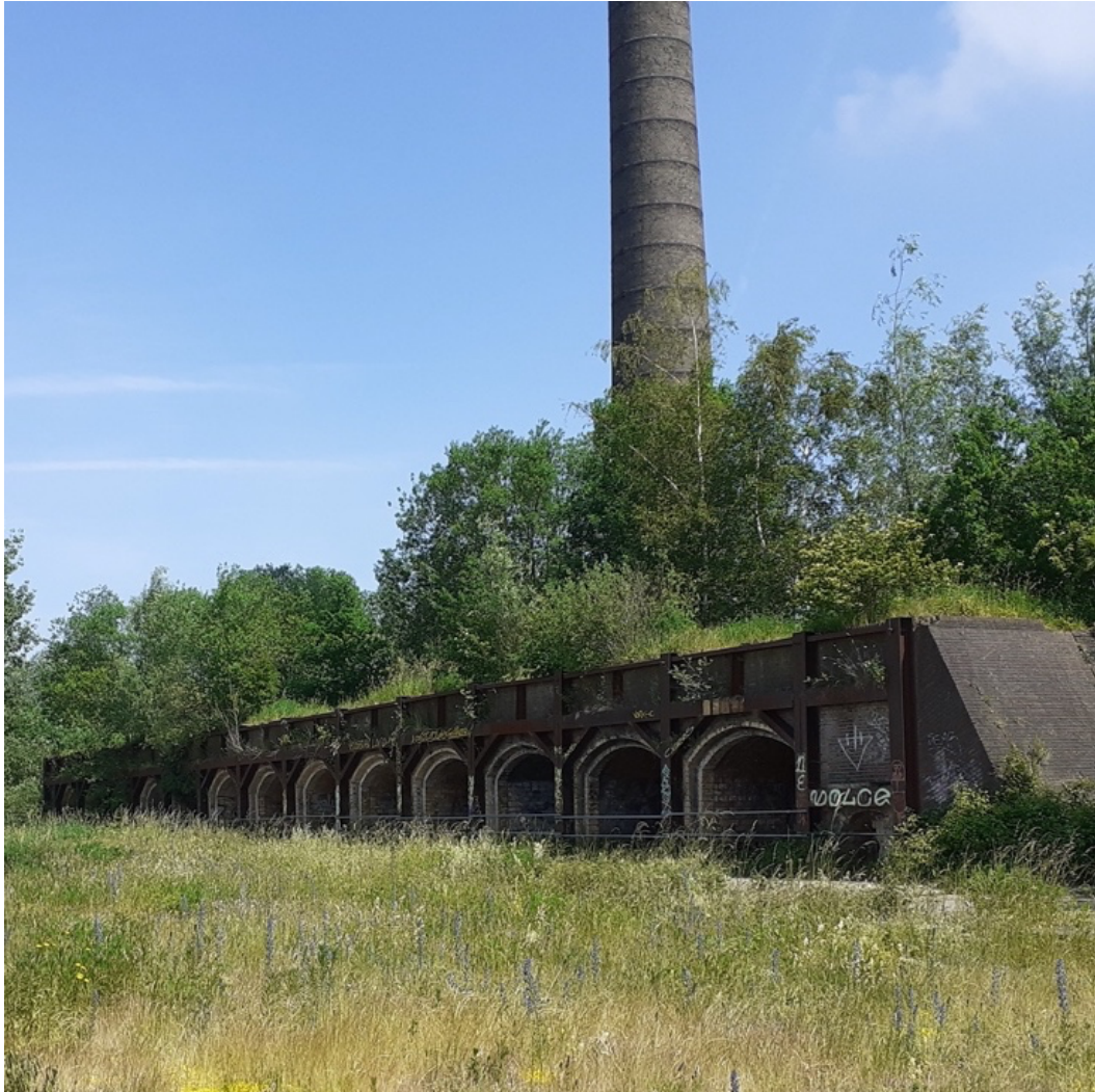
Figuur 6. Opgaande begroeiing op het dak van de ovens.
