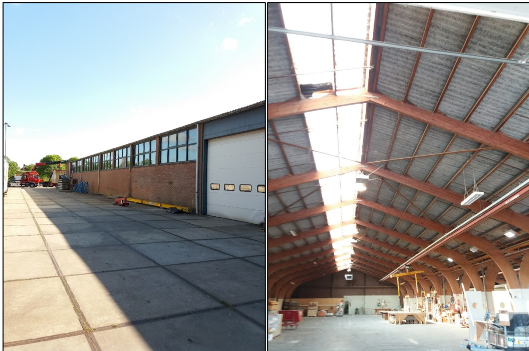
Figuur 3 Westzijde (links) en binnenzijde van de loods(en) (rechts).
