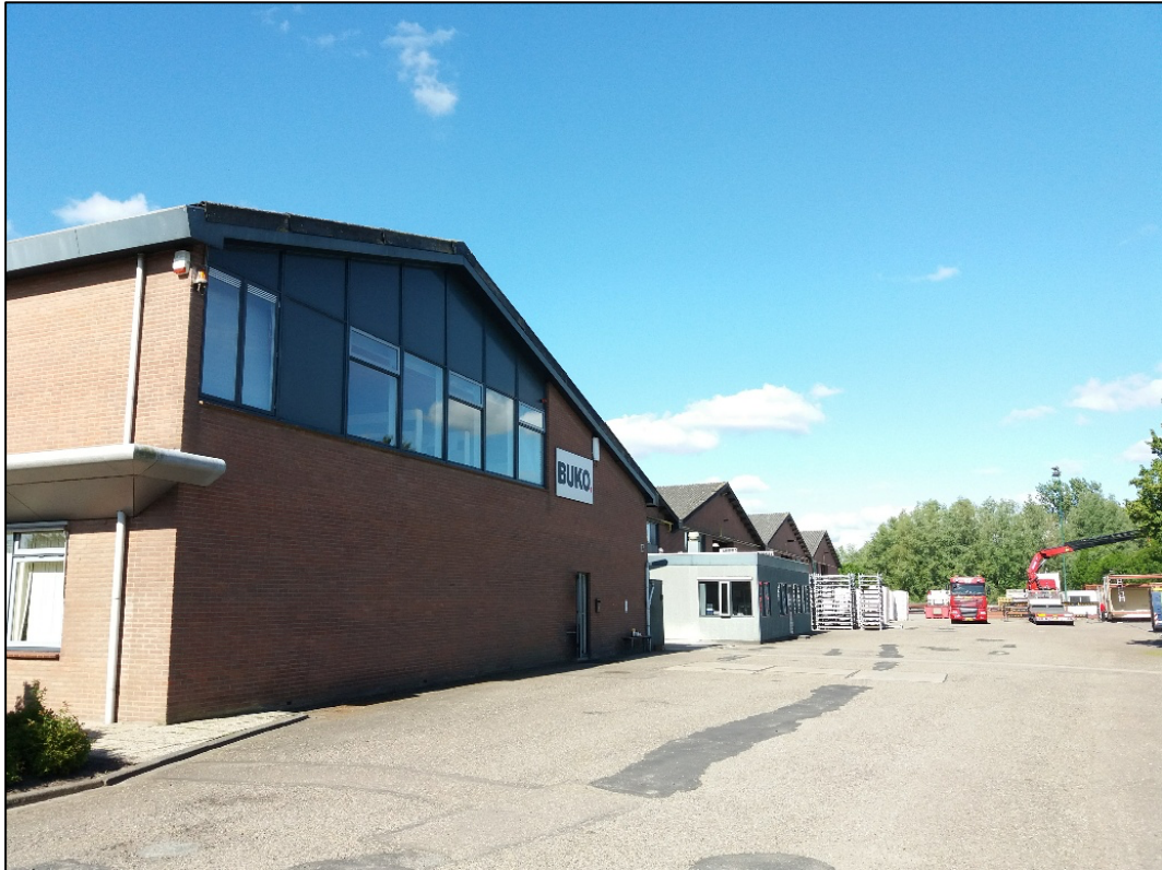
Figuur 2 Voorzijde van het BUKO-gebouw, bestaande uit het kantoorgebouw (voorground) en loodsen (achtergrond).
