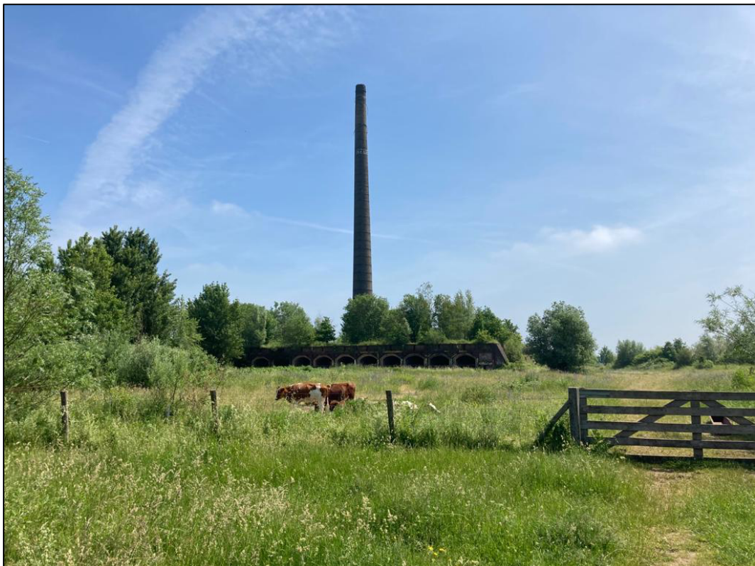
Figuur 1. De steenfabriek op het Heuff-terrein.
