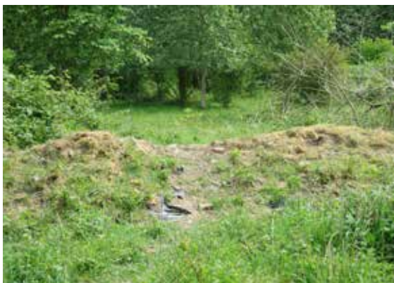
verhoging zomerkade met o.a. puin en plastic
