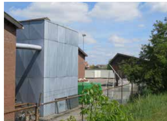
zicht op terrein BUKO
