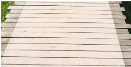
brug en vlonder van hout
