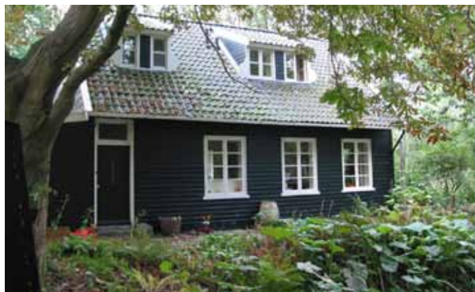
houten Verboden Kringenwetwoning
