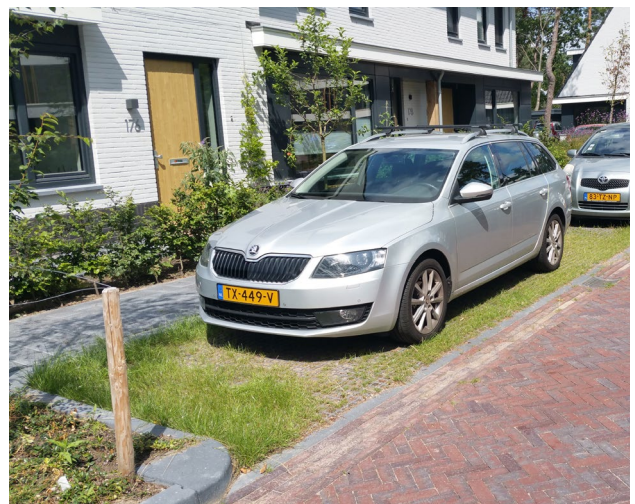
Parkeren langs de straat vindt plaats op halfverharding
