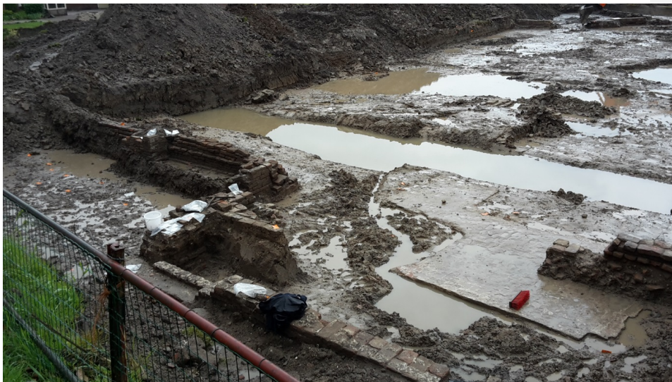
Bijlage 7.7-figuur 3. Overzicht van de funderingen in het zuiden van WP1, opname in westelijke richting.
