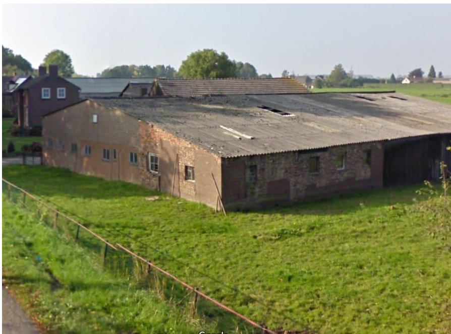
Figuur 6.8. De zuidoosthoek van de schuur die nog in oktober 2010 aanwezig was, bestond uit muurwerk zoals dat bij de verbouwing van 1935 tot stand gekomen was. Links van de hoek zien we het muurwerk van de zuidelijke zijgevel van het woonhuis, rechts van de hoek de voorgevel van het woonhuis, op het oosten gericht. Op de achtergrond staat het woonhuis Kerkstraat 2, de nieuwbouw die de oude boerderij verving (bron: Google Streetview, oktober 2010).
