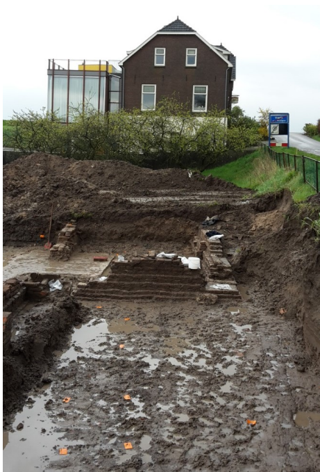
Bijlage 7.7-figuur 2. Overzicht van de funderingen in het zuiden van WP1, opname in oostelijke richting, met de bebouwing langs de Waalbandijk op de achtergrond.
