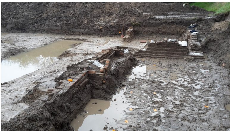
Bijlage 7.7-figuur 1. Overzicht van de funderingen in het zuiden van WP1, opname in oostelijke richting.
