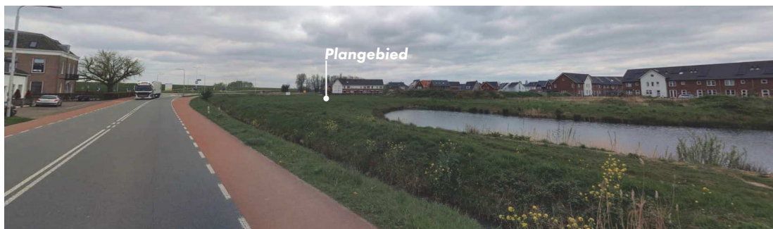
► Zicht op locatie. Prominent langs de N830 gelegen, de toegansweg richting Klingelberg en de historische kern van Tuil. Aan de linkerkant het voormalige districtskantoor.
