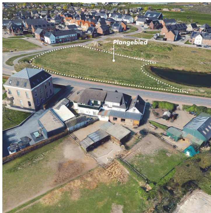
► Zicht op locatie. Op de achtergrond de reeds gerealiseerde fase 1 en 2 van Klingelenberg. Op de voorgrond het voormalige districtskantoor.
