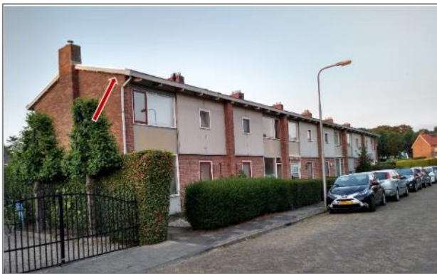
Afbeelding 4.1 | Locatie invliegopening zomerverblijfplaats gewone dwergvleermuis Rodenburgstraat 12.
