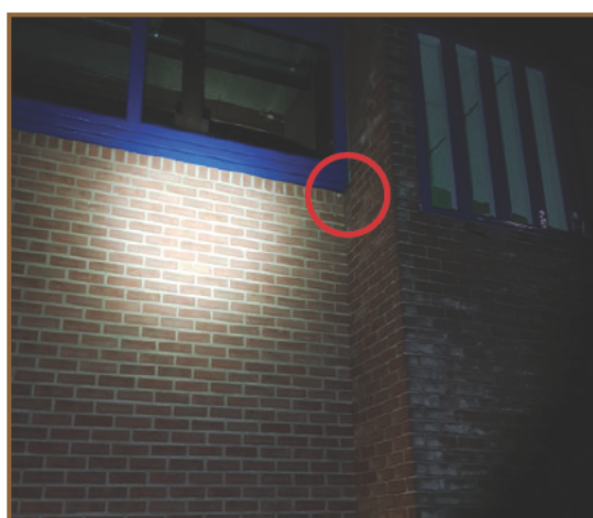
Afbeelding 3.2: Aan de zuidkant van de werkschuur/kantoor is een verblijfplaats van de gewone dwergvleermuis welke invliegend is waargenomen.
