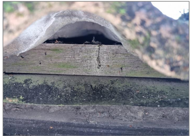
Afbeelding 4.4 | Door het ontbreken van vogelschroot is onder de ronde dakpannen ruimte voor huismus aanwezig om tot broeden te komen.
