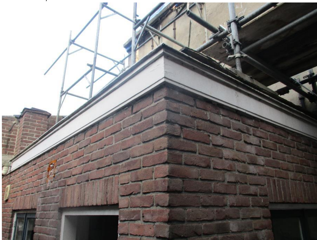
Figuur 2 Het kleine bijgebouw aan de zuidzijde heeft een plat bitumen dak.
