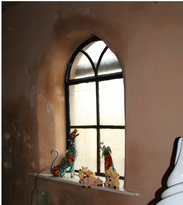
Gevelkozijnen aanzicht binnenzijde
