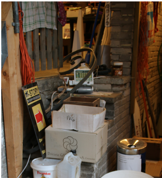
Bestaande rechtermuur laadperron
