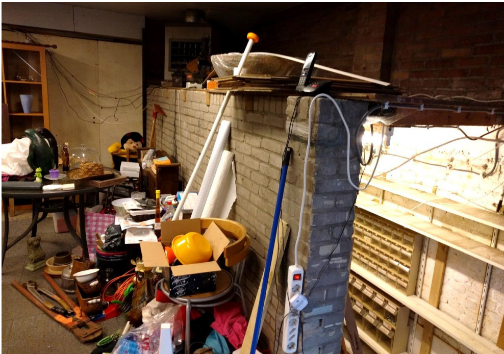
7 De zijmuren van het laadperron zijn van kalkzandsteen.
