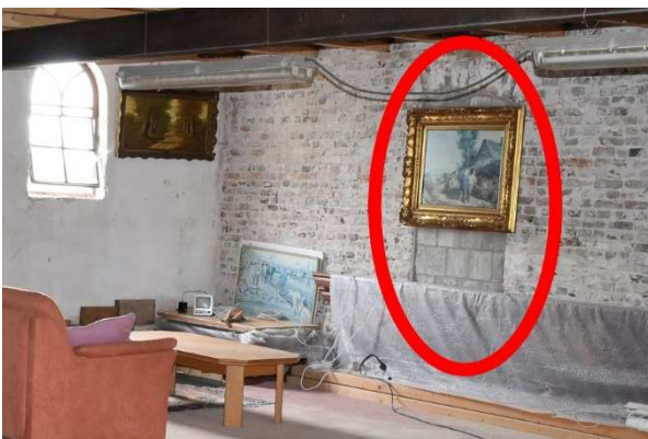
De recent dichtgemetselde muuropening.
