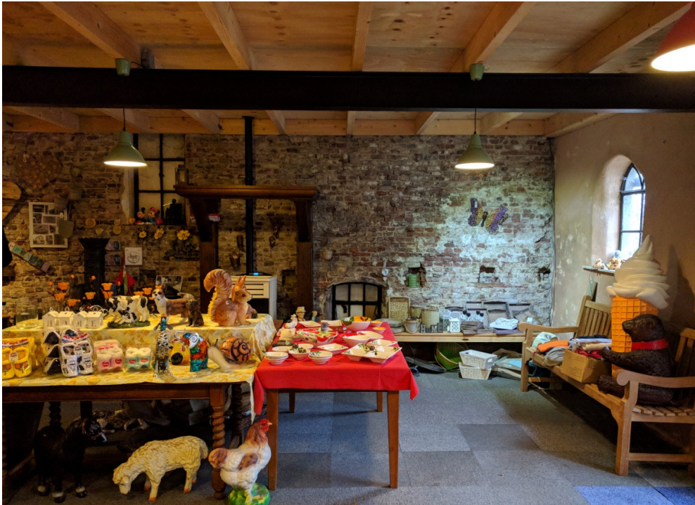
8 De kassen van de maalstoel zijn in de rechter zijgevel duidelijk zichtbaar. Het lage raam heeft in de kelder onder de maalstoel gezeten. Duidelijk is zichtbaar dat dit raam later is aangebracht.
