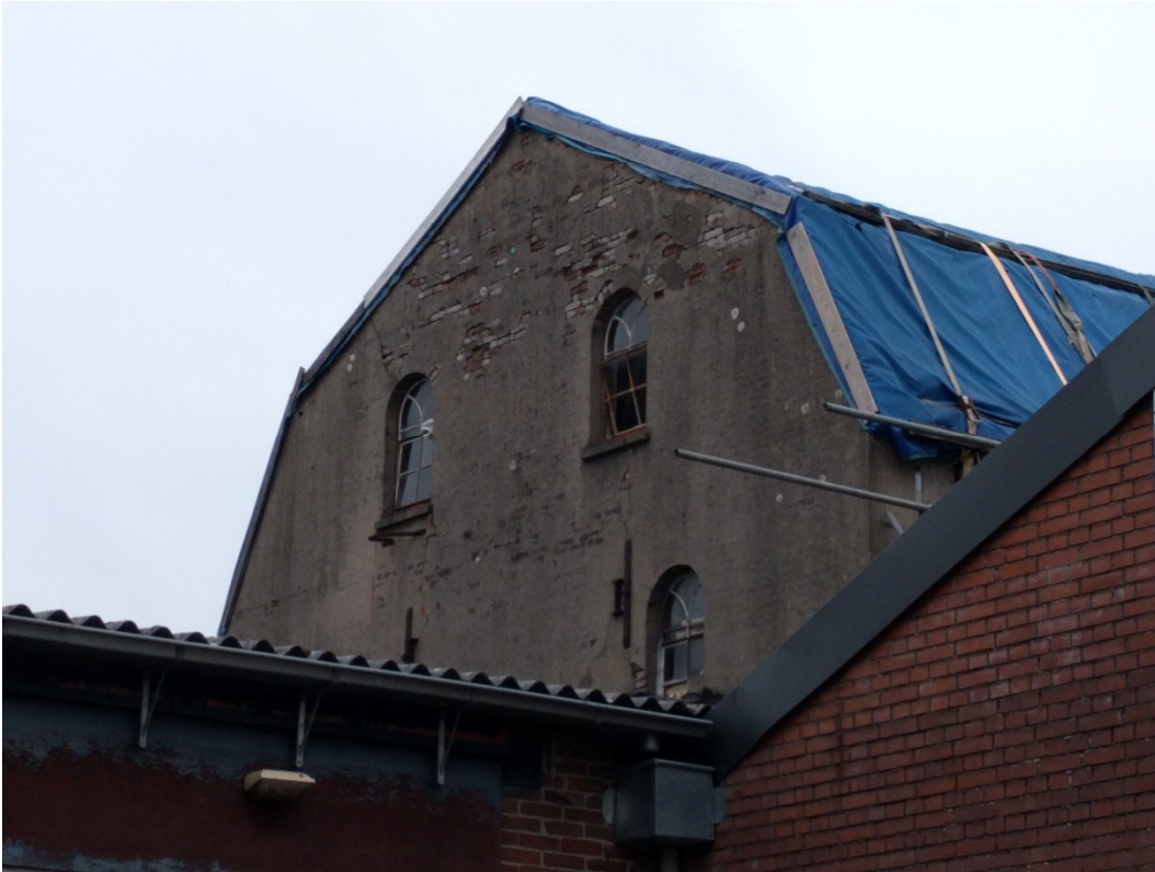
3 De achtergevel van het pand. De gietijzeren vensters zijn van hetzelfde type.
