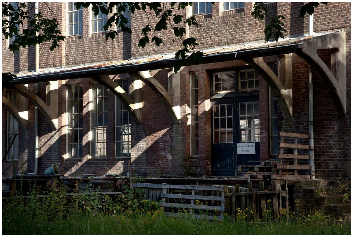
Overkapping van een laadperron in Oisterwijk in beton. Vaak waren deze overkappingen in staal gemaakt.
