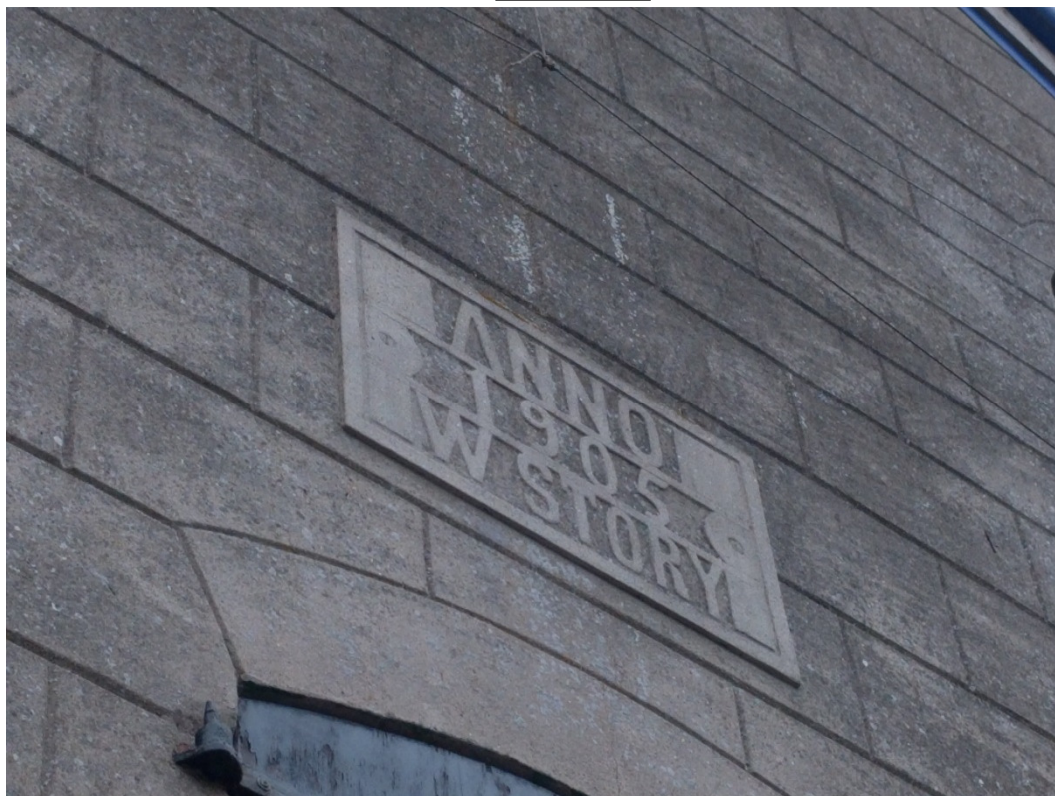
De voorgevel is gepleisterd. De “gevelsteen” is in het pleisterwerk opgenomen.
