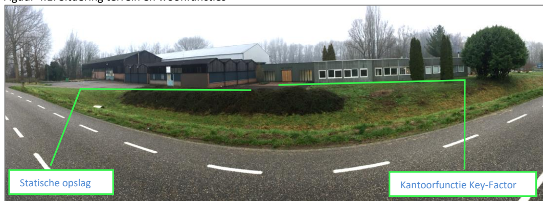
Figuur 4.2: Terrein Waaldijk 4 (gezien vanaf Waaldijk)
