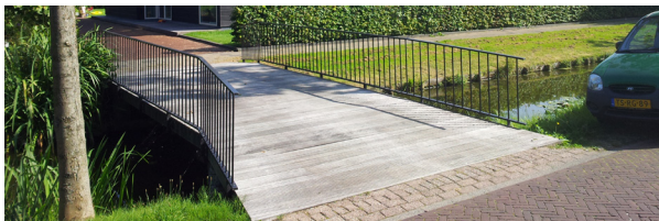
Voorbeelden van een brug/dam-duiker naar het eigen perceel
