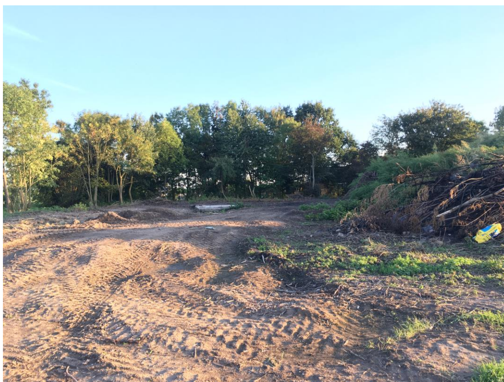
Figuur 2 Het perceel is grotendeels braakliggend. Op de zuidzijde is een groenstructuur aanwezig. Te midden van het perceel is een betonnen put en aan de noordoostzijde een betonnen bassin gesitueerd.
