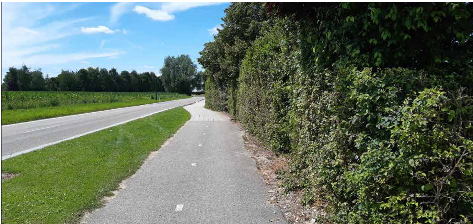
De huidige bosplantsoen aansluitend op het fietspad staat dermate dicht op het fietspad, dat het jaarlijks gesnoeid moet worden om te voorkomen dat het fietspad overgroeit raakt. Tevens wordt het uitzicht belemmerd, waardoor regelmatig gevaarlijke situaties ontstaan.
